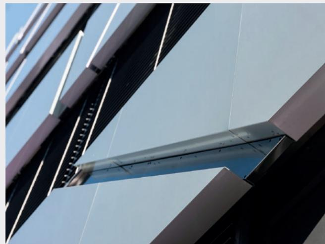
Höchste Präzision bei Fertigung und Montage: Auf die gesamte Gebäudehöhe musste eine Genauigkeit von rund 2 mm eingehalten werden.
